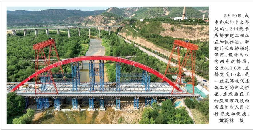
5月29日,我市和庆阳市交界处的G244线正在加快推进。新建的长庆桥横跨泾河,设计为双向两车道桥梁,全长310.6米,主桥宽度19米,是一座充满现代建筑工艺的新式桥梁,建成后我市和庆阳市及陕西省咸阳市人民出行将更加便捷。黄蔚林 摄
