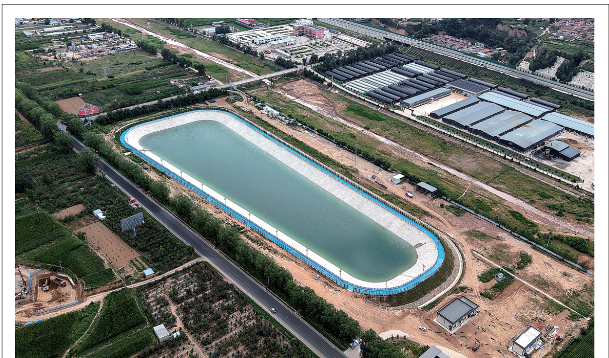
图为引洮二期庄浪应急供水工程蓄水池。8月12日,庄浪县举行城区洮河水源供水切换仪式。近年来,庄浪县委、县政府把解决水资源短缺问题作为全县发展的重大战略,投资7.28亿元实施了引洮二期庄浪应急供水工程,经过三年多的接续奋战,顺利切换通水,解决了多年来困扰全县人民的饮水难问题。 本报记者 董春辉 摄
