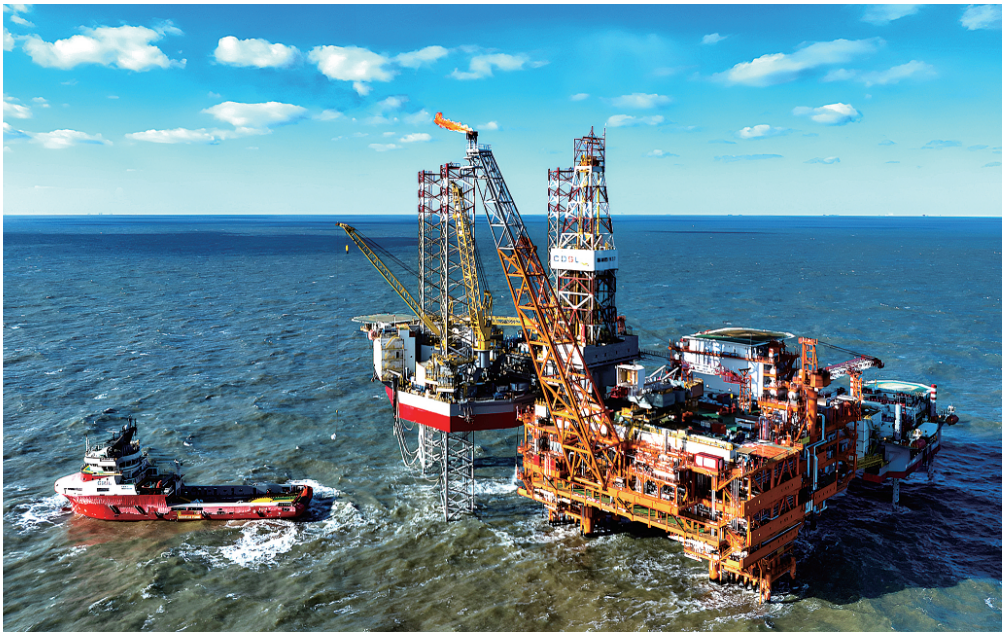
这是2025年2月8日拍摄的渤中26-6油田一期开发项目海上作业平台(无人机照片) 新华社发(杜鹤辉 摄)
