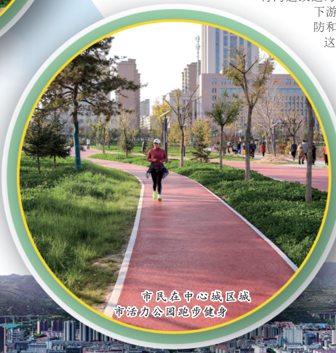
中心城区五里墩路绿化工程配套建设的透水砖铺装工程(无人机照片)
